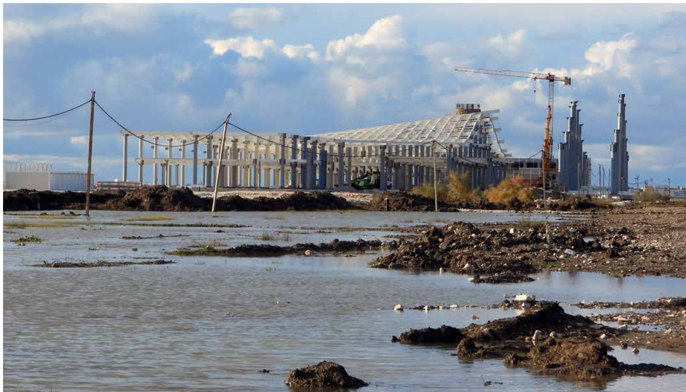
Trotz laufender Gerichtsverfahren und Kritik der Berner Konvention und von EU-Institutionen baut die albanische Regierung den Flughafen Vlora weiter. Sie schlägt alle Warnungen und Bedenken in den Wind. Im Bild ist der geplante Hangar zu erkennen.
