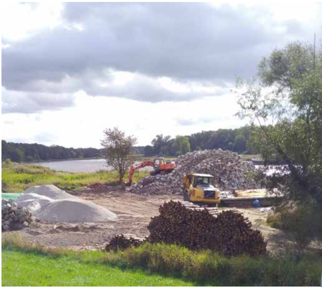
Bauarbeiten an der Oder, trotz des aufrüttelnden Massenfischsterbens im vergangenen Jahr.
