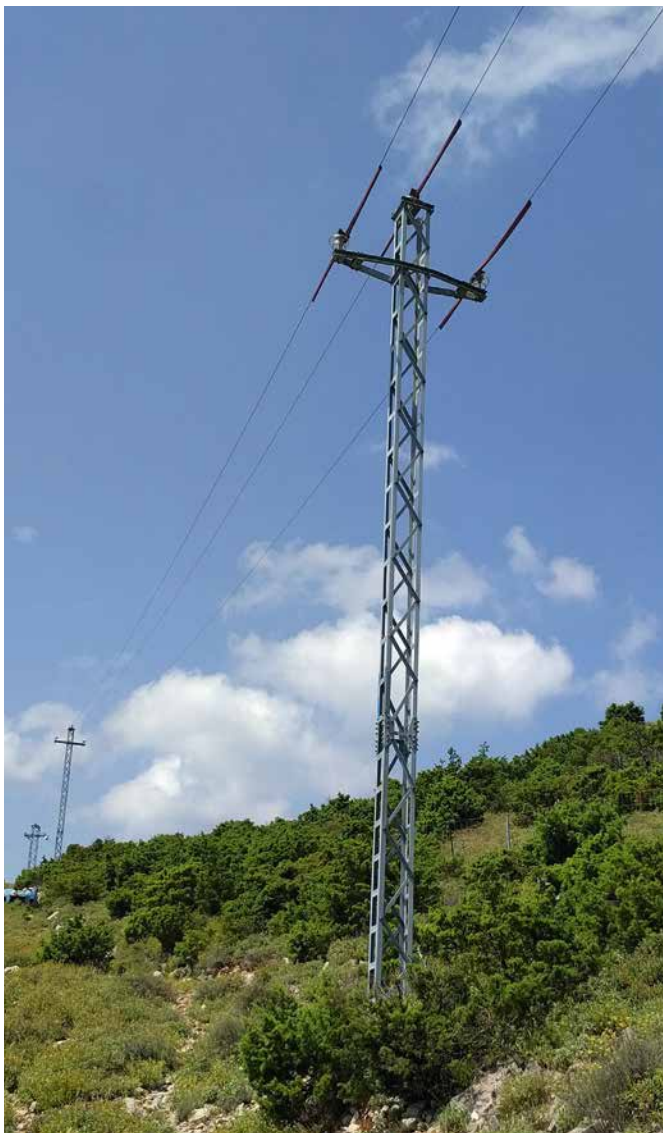
Gesicherter Strommast auf der kroatischen Insel Cres. Doch auch hier gibt es noch ungesicherte Leitungen. Unter diesen suchen Freiwillige unserer kroatischen Partnerorganisation BIOM nach toten Vögeln.
